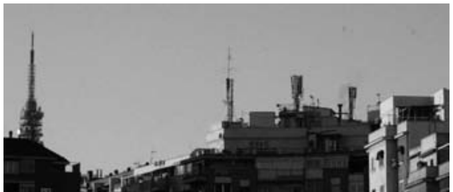
Antenas de telefonía en el madrileño barrio de Fuente del Berro.
