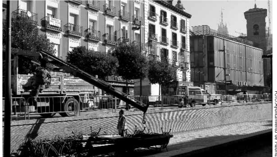
Obras iniciadas por el Ayuntamiento en la plaza de la Luna
